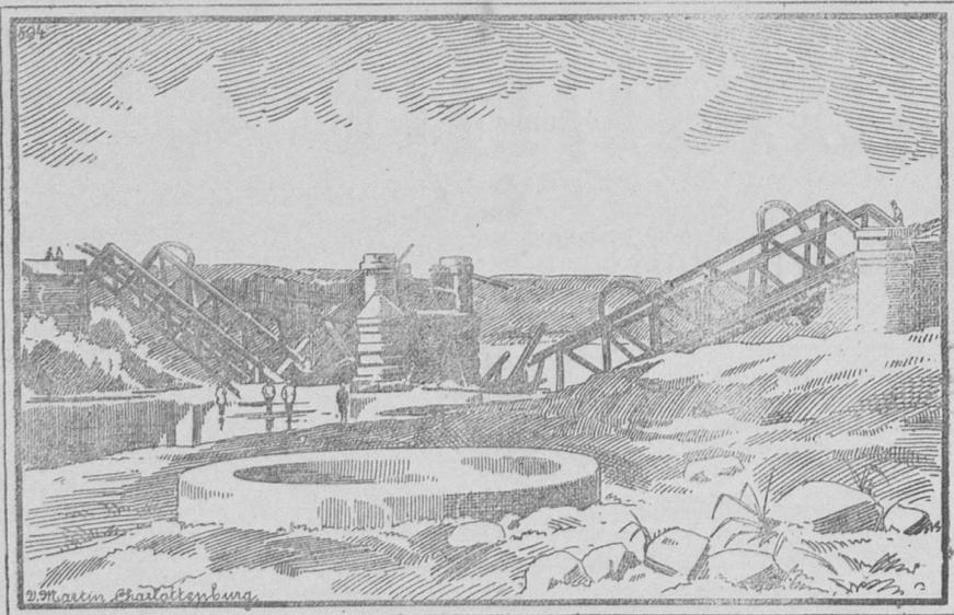
Sprengung hat bei dem mittleren Pfeiler stattgefunden und zu beiden Seiten sind die schweren Eisenkonstruktionen der Brücke in den Fluß hinuntergerollt. Aus unserem Bilde geht deutlich hervor, mit wie großen Schwierig-
