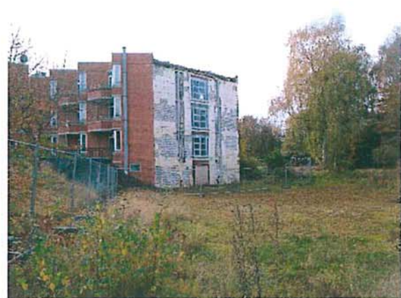
Abb. 3 Spuren des Abrisses am Alten- und Pflegeheim im nördlich Planbereich (P. Scharlibbe 26.10.2012)
