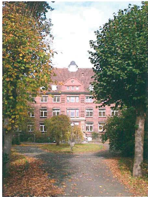
Abb. 7 Blick auf den Eingangsbereich „Haus Elbmarsch“ mit begleitender Lindenallee vom Sandberg aus (P. Scharlibbe 26.10.2012)
