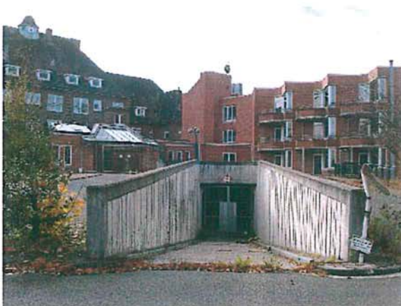
Abb. 4 noch bestehende Tiefgaragenzufahrt von der Stellplatzanlage im mittleren Planbereich (P. Scharlibbe 26.10.2012)
