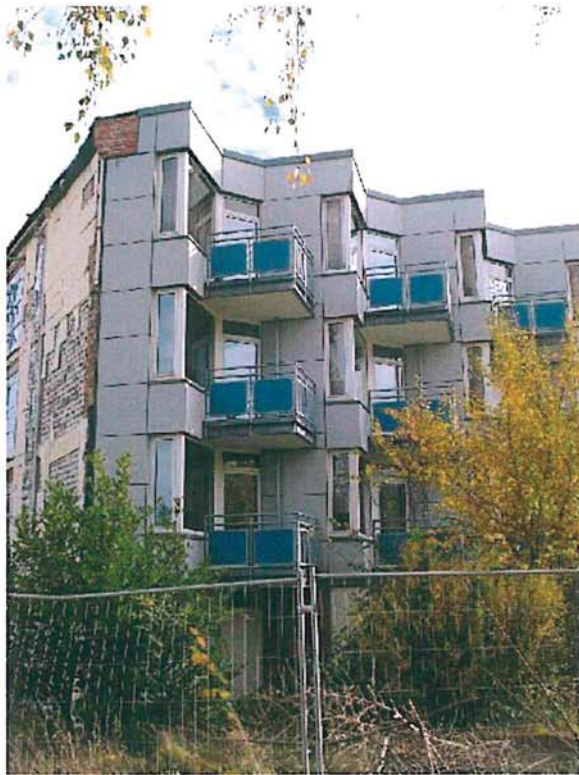
Abb. 6 Teil-Abriss des leer stehenden Alten- und Pflegeheimes (P. Scharlibbe 26.10.2012)
