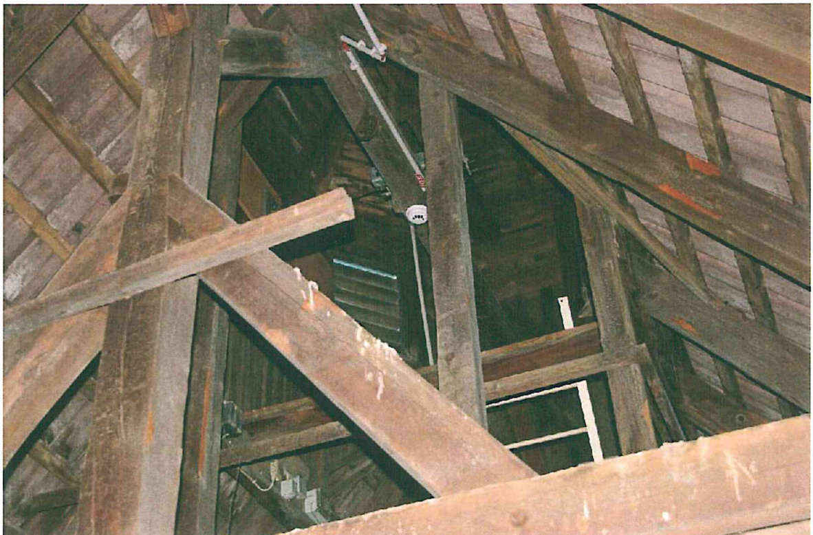
Abbildung 2-3: Dachstuhl des ehemaligen Alten- und Pflegeheimes
