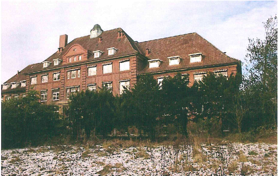
Abbildung 2-2: Hauptgebäude (Haus Elveshörn) des ehemaligen Alten- und Pflegeheimes
