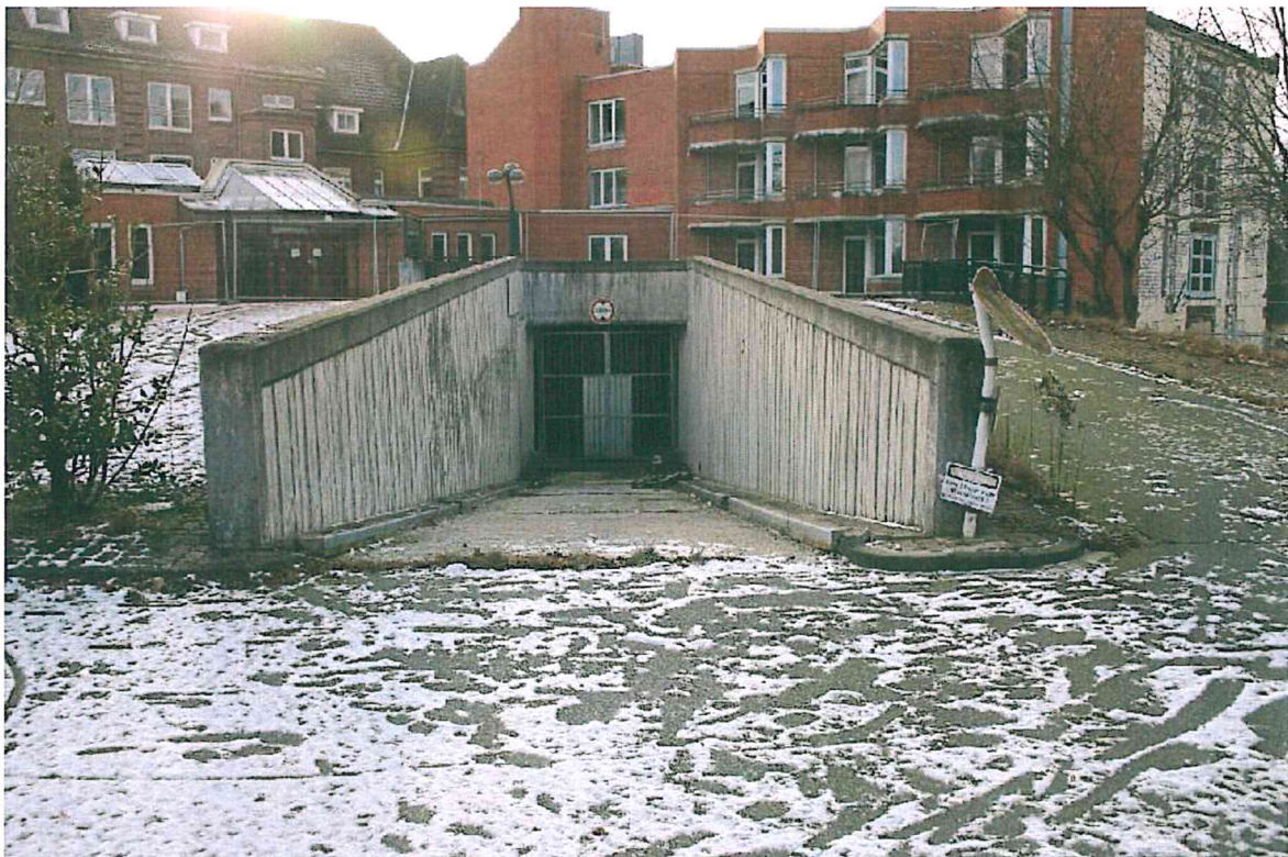
Abbildung 2-5: Einfahrtbereich der Tiefgarage
